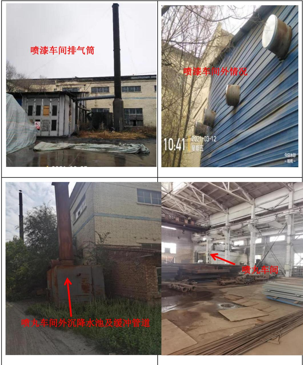
图 4-5 总装车间废气处理设施
