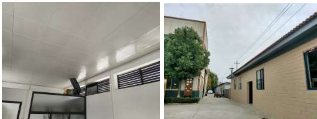
图 3-2 废气处理设施
